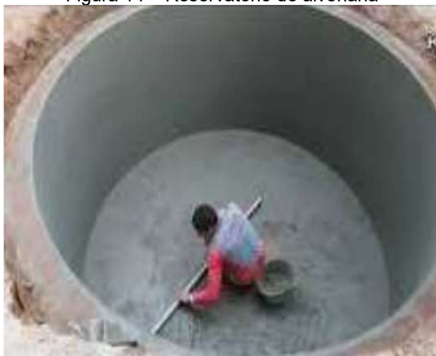
Figura 14 – Reservatório de alvenaria
