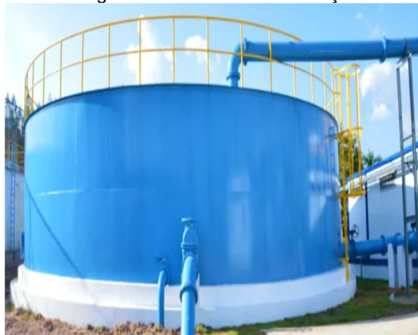
Figura 16 – Reservatório de aço
