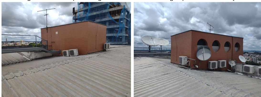
Figura 37 – Local para abrigo dos reservatórios de água potável da edificação
