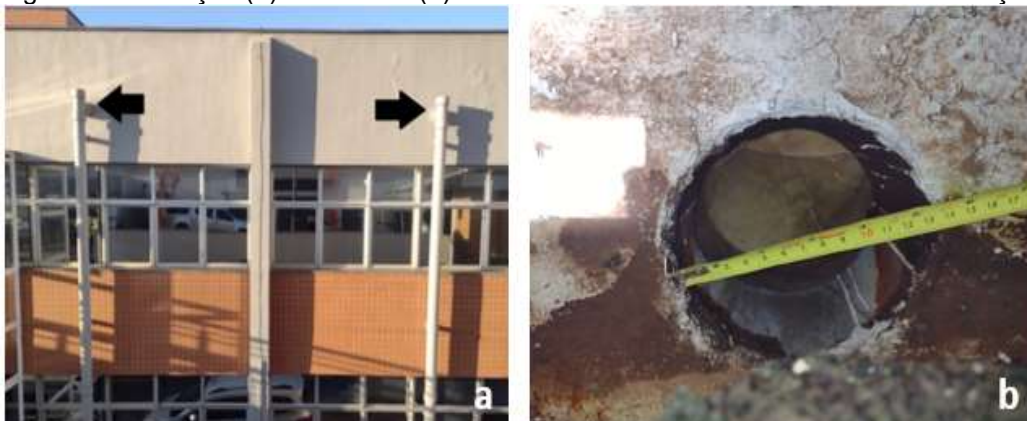
Figura 31 – Posição (a) e diâmetro (b) dos condutores verticais instalados na edificação
