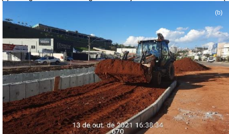
Figura 38 – Fotografia do reaterro das bordas do trecho de aduelas (a). Fotografia da compactação das bordas do trecho de aduelas (b). Fotografia da execução do meio-fio das calçadas do trecho de aduelas (c). Fotografia da concretagem das calçadas do trecho de aduelas (d).
