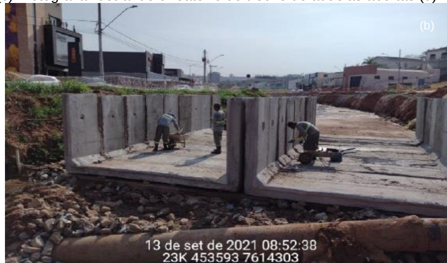
Figura 35 – Fotografia ilustrando as aduelas abertas disponíveis para instalação (a). Fotografia ilustrando a instalação das aduelas abertas (b). Fotografia ilustrando a etapa de rejunte entre as peças das aduelas (c). Fotografia ilustrando o reaterro do trecho de aduelas abertas (d).
