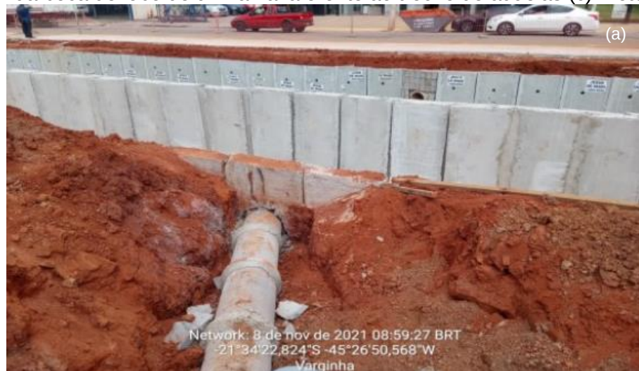
Figura 40 – Foto de um ramal aferente ao trecho de aduelas - a (a). Foto de um ramal aferente ao trecho de aduelas– b (b). Foto da execução da boca de lobo de um ramal aferente ao trecho de aduelas (c). Foto da finalização da concretagem das calçadas do trecho de aduelas (d).
