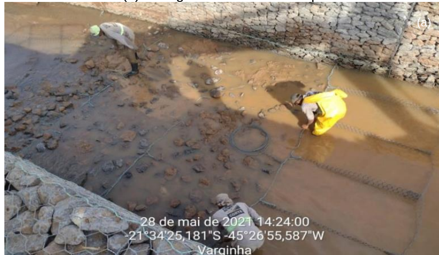
Figura 30 – Fotografia ilustrando a execução do colchão reno do trecho de gabião (a). Fotografia ilustrando a locação topográfica do trecho de aduelas abertas (b). Fotografia ilustrando a limpeza do trecho de aduelas (c). Fotografia ilustrando a escavação do trecho de aduelas (d).
