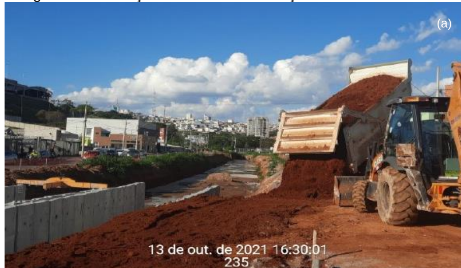
Figura 38 – Fotografia do reaterro das bordas do trecho de aduelas (a). Fotografia da compactação das bordas do trecho de aduelas (b). Fotografia da execução do meio-fio das calçadas do trecho de aduelas (c). Fotografia da concretagem das calçadas do trecho de aduelas (d).
