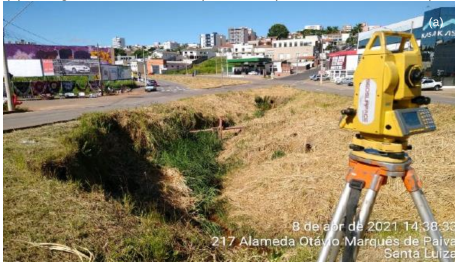
Figura 26 – Fotografia ilustrando a etapa de locação topográfica do trecho de gabião (a). Fotografia ilustrando a limpeza do trecho de gabião (b). Fotografia ilustrando a etapa de transporte do material de limpeza (c). Fotografia ilustrando a escavação do leito do trecho de gabião (d).
