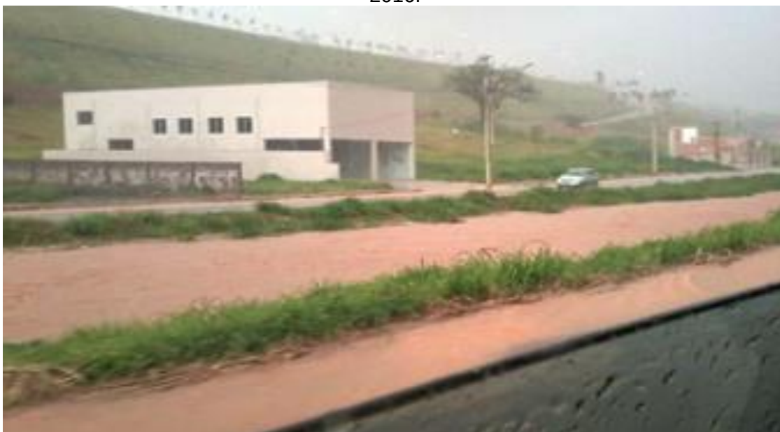
Figura 1 – Inundação ocorrida na Avenida Otávio Marques de Paiva em fevereiro de 2016.
