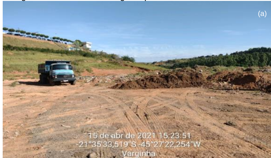
Figura 27 – Fotografia ilustrando a descarga em bota-fora de material escavado (a). Fotografia ilustrando o recebimento de pedra de mão (b). Fotografia ilustrando a descarga de pedra de mão no leito do trecho de gabião (c). Fotografia ilustrando a montagem das telas de gabião (d).
