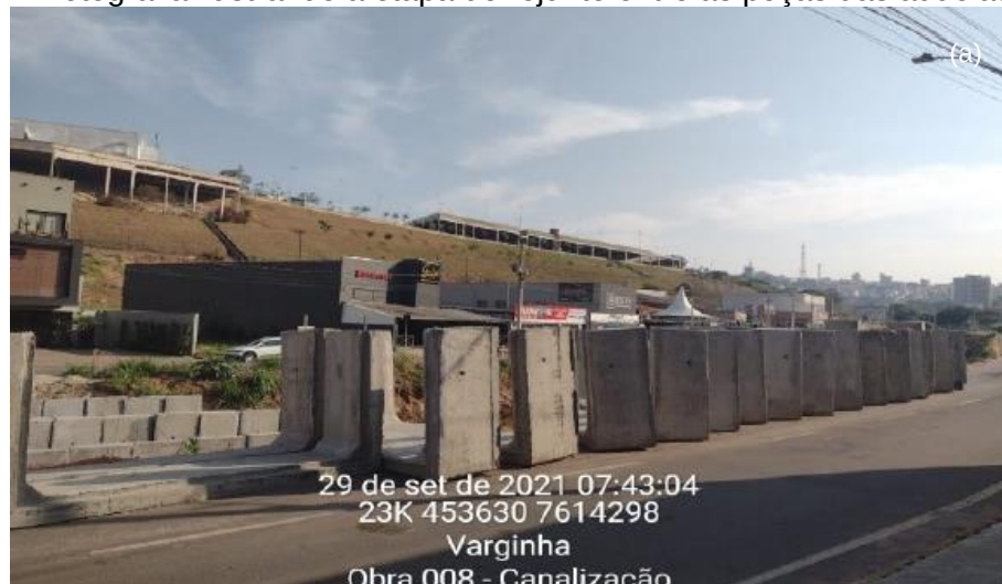
Figura 35 – Fotografia ilustrando as aduelas abertas disponíveis para instalação (a). Fotografia ilustrando a instalação das aduelas abertas (b). Fotografia ilustrando a etapa de rejunte entre as peças das aduelas (c). Fotografia ilustrando o reaterro do trecho de aduelas abertas (d).
