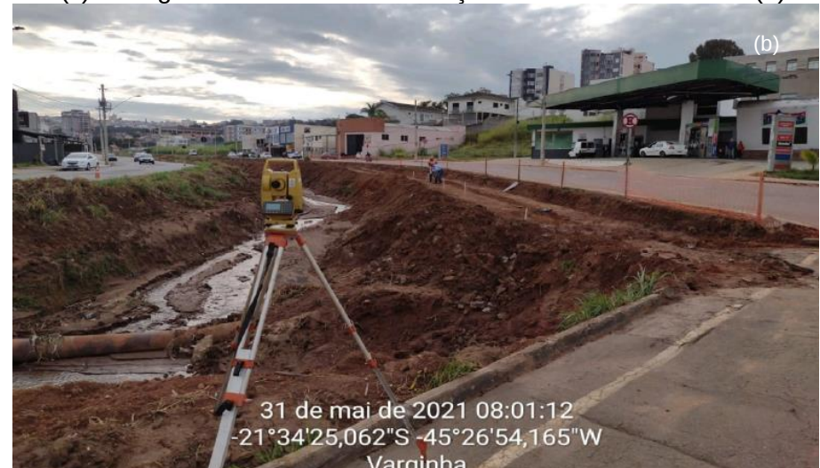
Figura 30 – Fotografia ilustrando a execução do colchão reno do trecho de gabião (a). Fotografia ilustrando a locação topográfica do trecho de aduelas abertas (b). Fotografia ilustrando a limpeza do trecho de aduelas (c). Fotografia ilustrando a escavação do trecho de aduelas (d).
