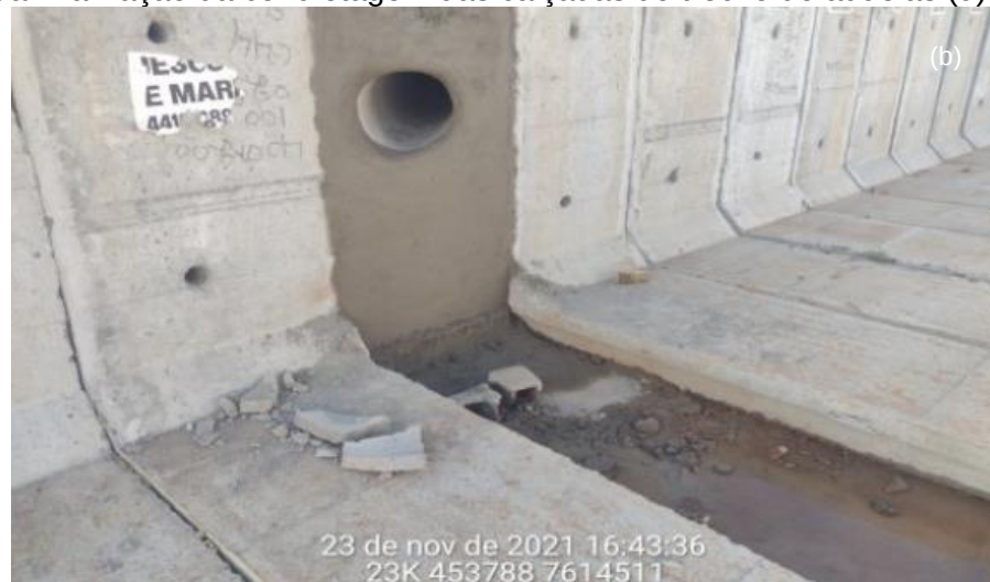
Figura 40 – Foto de um ramal aferente ao trecho de aduelas - a (a). Foto de um ramal aferente ao trecho de aduelas– b (b). Foto da execução da boca de lobo de um ramal aferente ao trecho de aduelas (c). Foto da finalização da concretagem das calçadas do trecho de aduelas (d).
