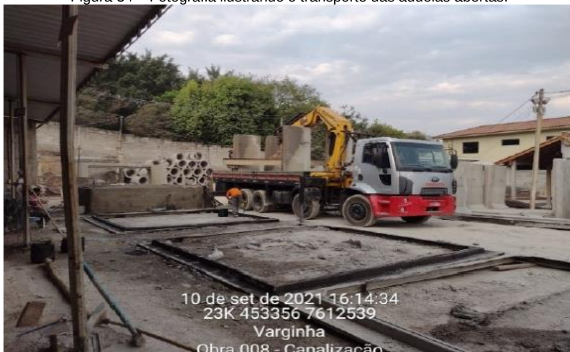
Figura 34 – Fotografia ilustrando o transporte das aduelas abertas.
