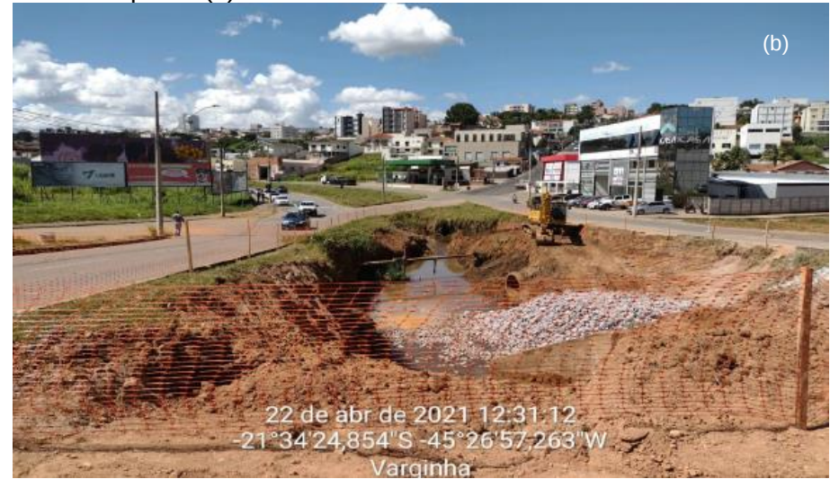
Figura 28 – Fotografia ilustrando a etapa de montagem do muro de gabião na porção final do trecho (a). Fotografia ilustrando a etapa de cercamento do local com tela-tapume (b).
