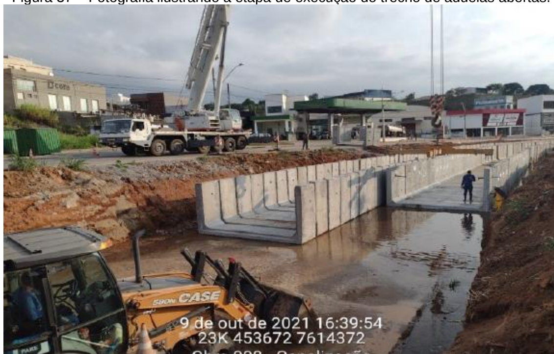
Figura 37 – Fotografia ilustrando a etapa de execução do trecho de aduelas abertas.
