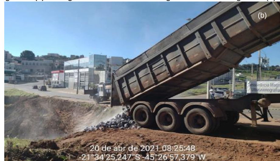
Figura 27 – Fotografia ilustrando a descarga em bota-fora de material escavado (a). Fotografia ilustrando o recebimento de pedra de mão (b). Fotografia ilustrando a descarga de pedra de mão no leito do trecho de gabião (c). Fotografia ilustrando a montagem das telas de gabião (d).
