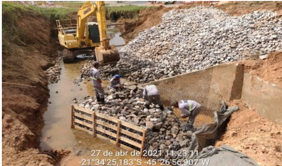
Figura 28 – Fotografia ilustrando a etapa de montagem do muro de gabião na porção final do trecho (a). Fotografia ilustrando a etapa de cercamento do local com tela-tapume (b).
