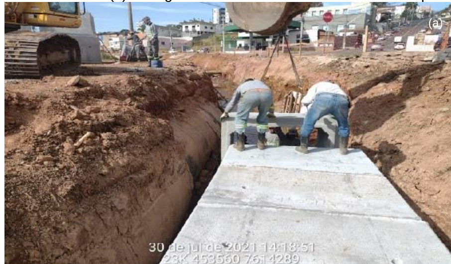
Figura 33 – Fotografia ilustrando o içamento das aduelas fechadas (a). Fotografia ilustrando a etapa de execução do segmento de aduelas fechadas (b). Fotografia ilustrando o fechamento de meia pista na região afetada pelo surgimento de trincas no leito asfáltico (c).
