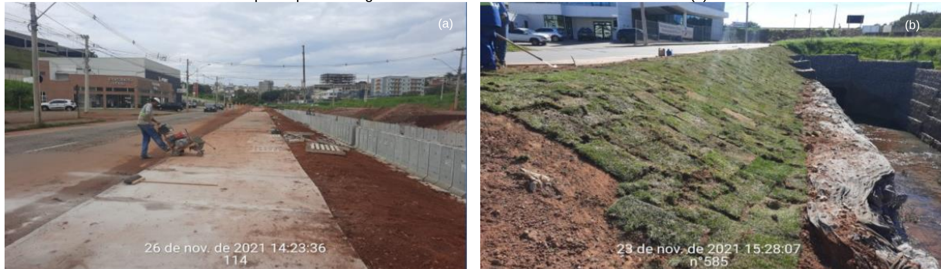
Figura 41 – Fotografia ilustrando a execução dos cortes de dilatação das calçadas do trecho de aduelas abertas (a). Fotografia ilustrando a etapa de plantio de grama nos taludes do trecho de aduelas abertas (b).
