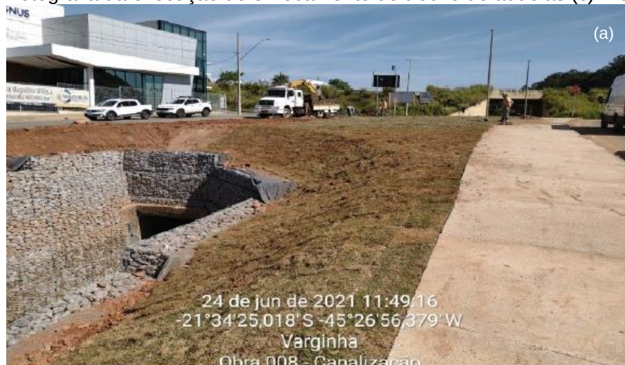
Figura 31 – Fotografia ilustrando o plantio de grama do trecho de gabião (a). Fotografia da concretagem da calçada do trecho de gabião (b). Fotografia da execução do enrocamento do trecho de aduelas (c). Fotografia da execução do piso de regularização do trecho de aduelas (d).
