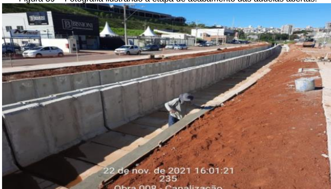
Figura 39 – Fotografia ilustrando a etapa de acabamento das aduelas abertas.
