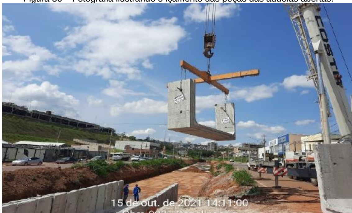
Figura 36 – Fotografia ilustrando o içamento das peças das aduelas abertas.
