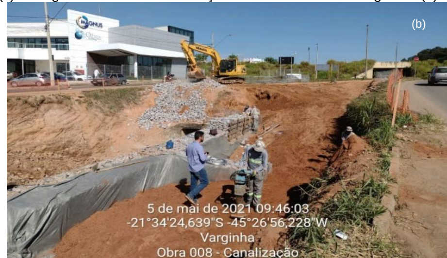
Figura 29 – Fotografia ilustrando a etapa de limpeza para reaterro do trecho de gabião (a). Fotografia ilustrando o reaterro do trecho de gabião (b). Fotografia ilustrando a execução do meio-fio do trecho de gabião (c). Fotografia ilustrando a execução dos muros laterais de gabião (d).
